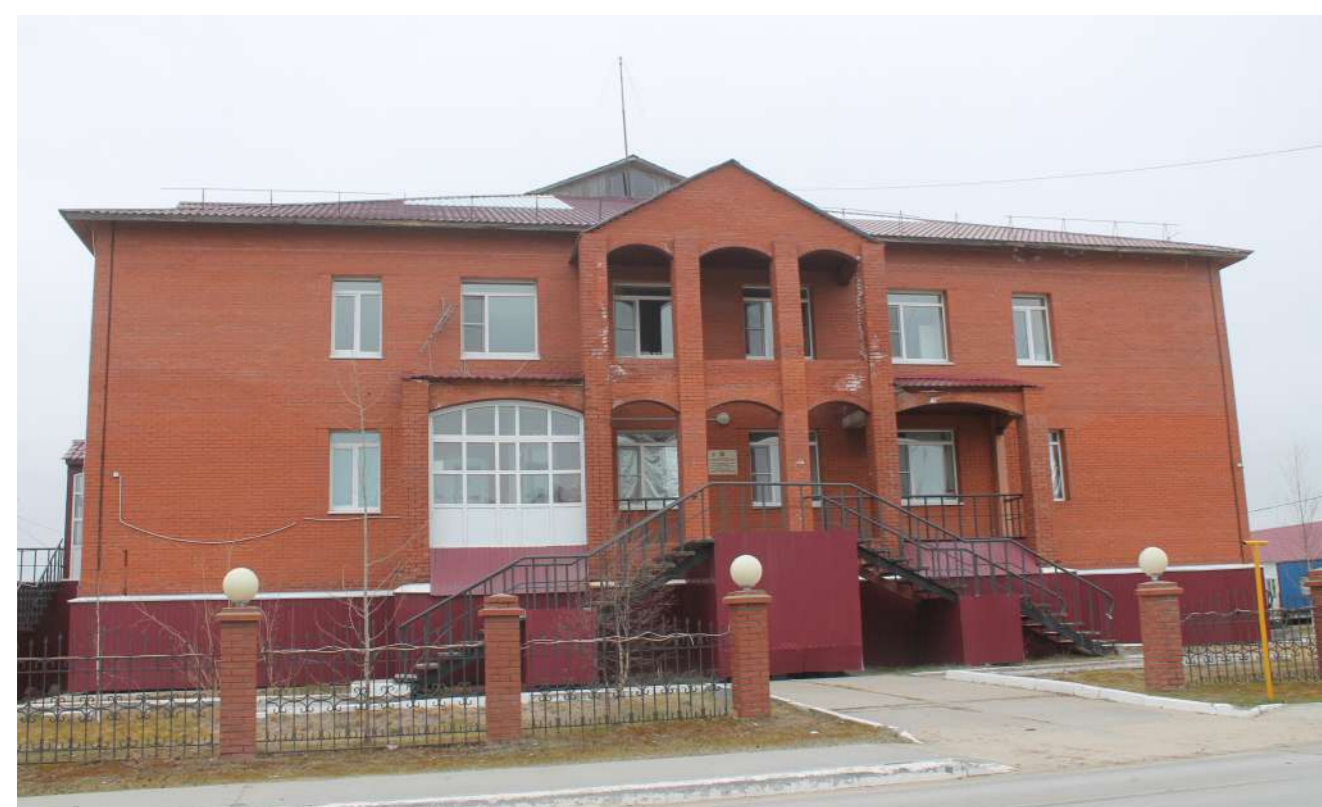
Обследование объекта: «Родильное отделение на 10 коек и соматическое отделение на 50 коек», расположенное по адресу: ЯНАО, с. Красноселькуп, ул. Полярная, д.3, корпус 7
