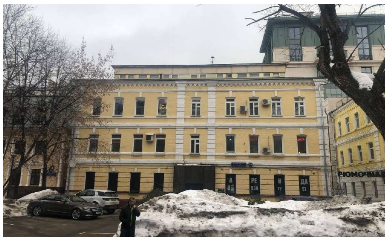
Обследование здания по адресу: г. Москва, ул. Малая бронная, 24, стр. 3
