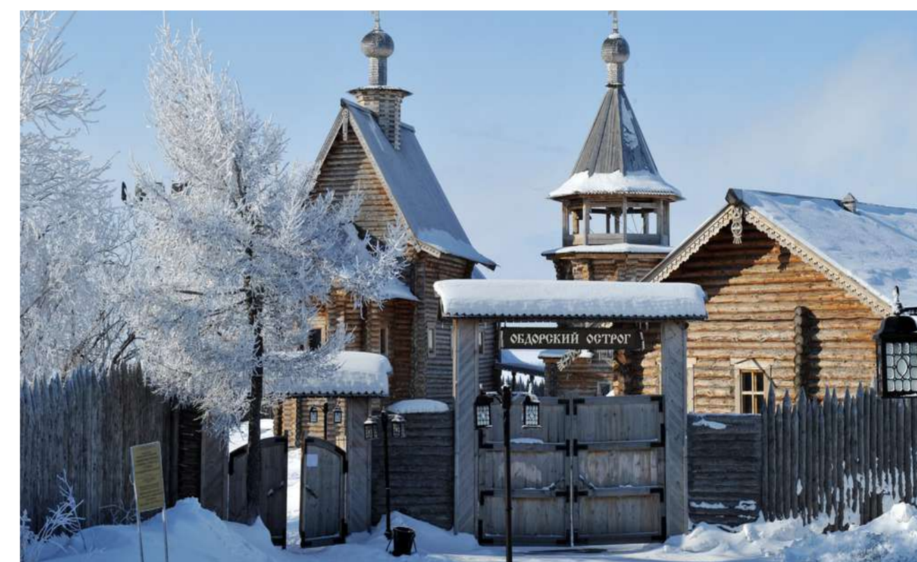
Обследование строительных конструкций и моделирование влияния существующих зданий историко-архитектурного коимплекса «Обдорский острог» на устойчивость грунтового массива оболочки зимника
