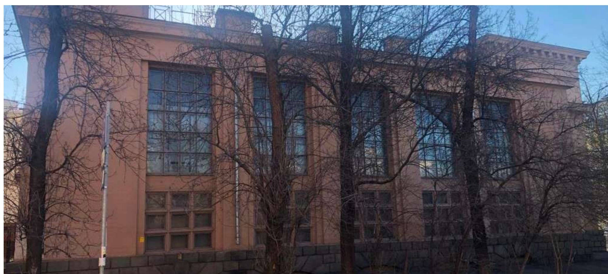
Обследования выявленного объекта культурного наследия «Электрическая станция, кон. 1930-х-1940-е гг. с оградой» по адресу: г. Москва, ул. Колпачный пер., д 13, стр.1, разработка проекта противоаварийных мероприятий, конструктивных и объемно-планировочных решений.
