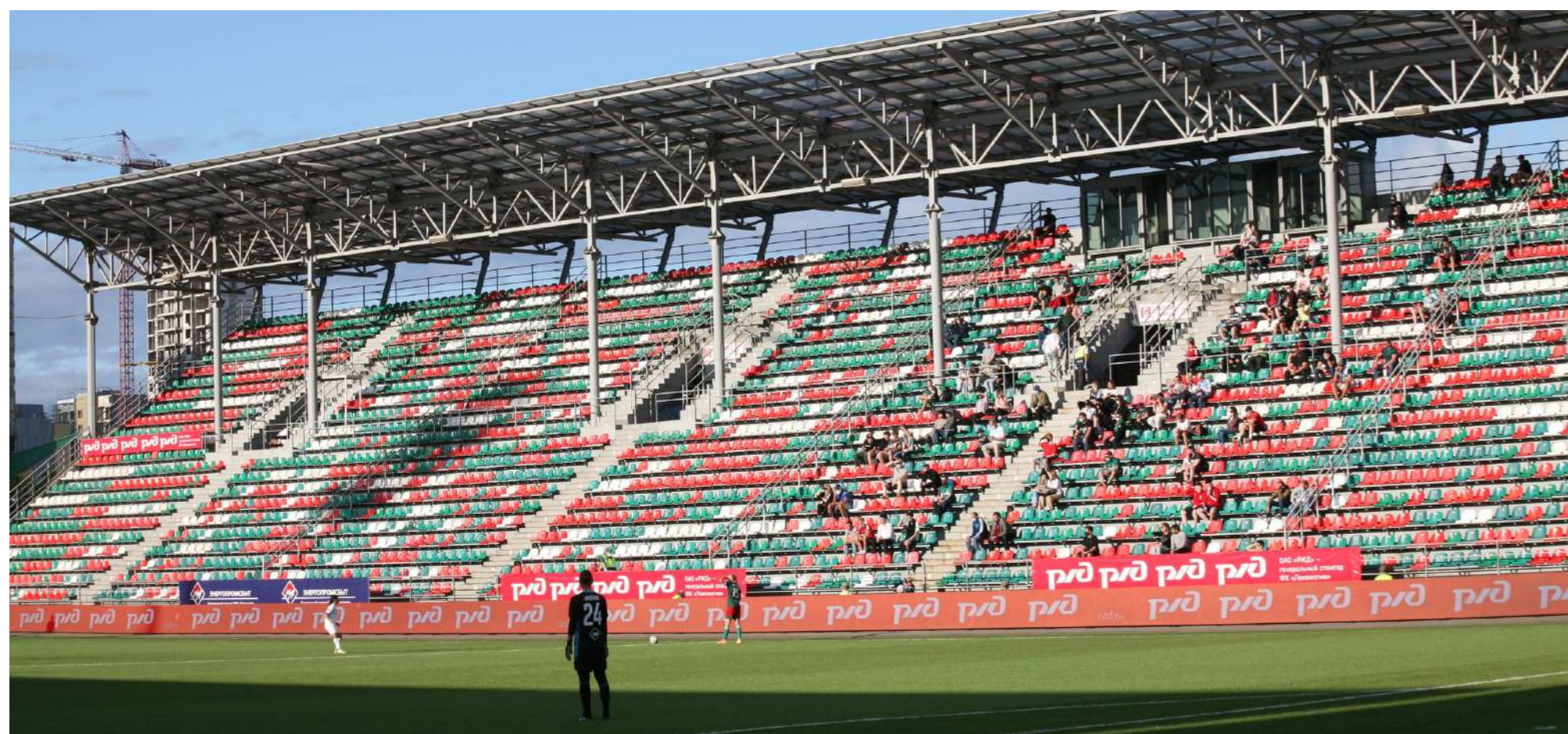
Обследование несущих конструкций трибун «Сапсан Арены»
