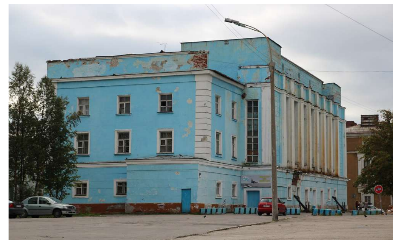
Обследование здания военно-морского музея Северного флота в г. Мурманск.
