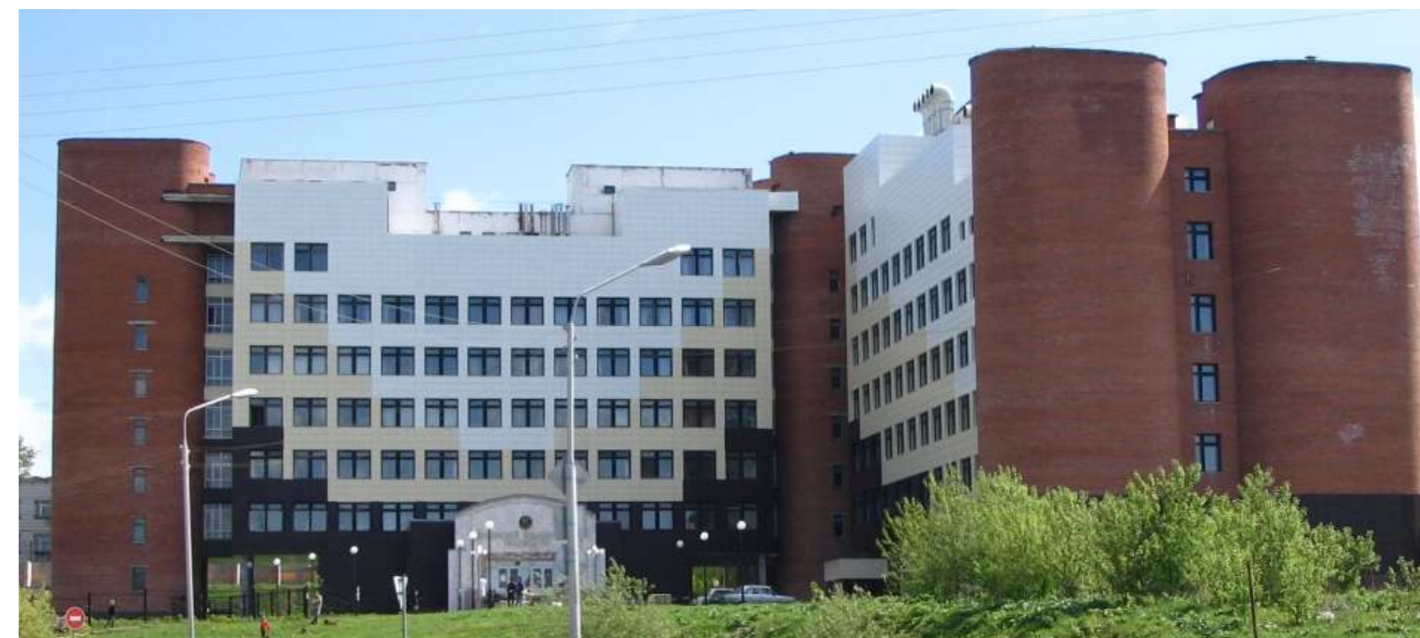
Проектирование капитального ремонта здания учебно-лабораторного корпуса СИБГМУ, расположенного по адресу: г. Томск, Московский тракт, 2, строение 7
